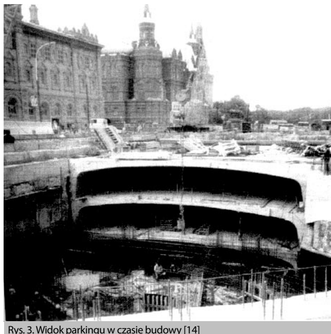
Rys. 3. Widok parkingu w czasie budowy [14]
